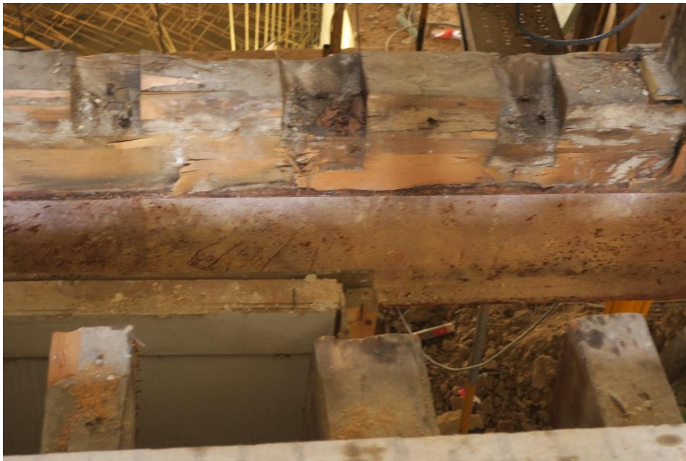
Fotografia 4 - Pormenor da intervenção de rebaixamento de piso - Corte das vigas existentes
