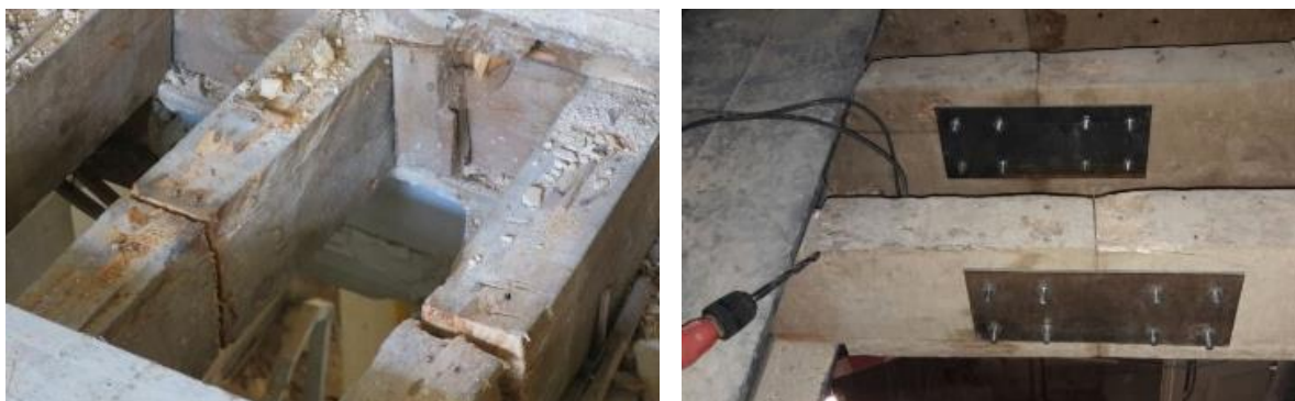
Figura 6.30 - Fotografia da intervenção tratada no Palacete do Príncipe Real
