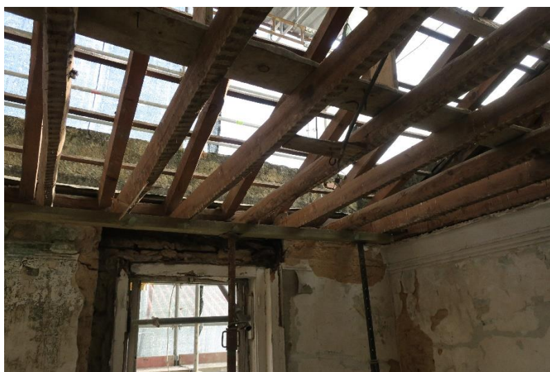
Fotografia 3 - Vista da Cobertura em madeira
