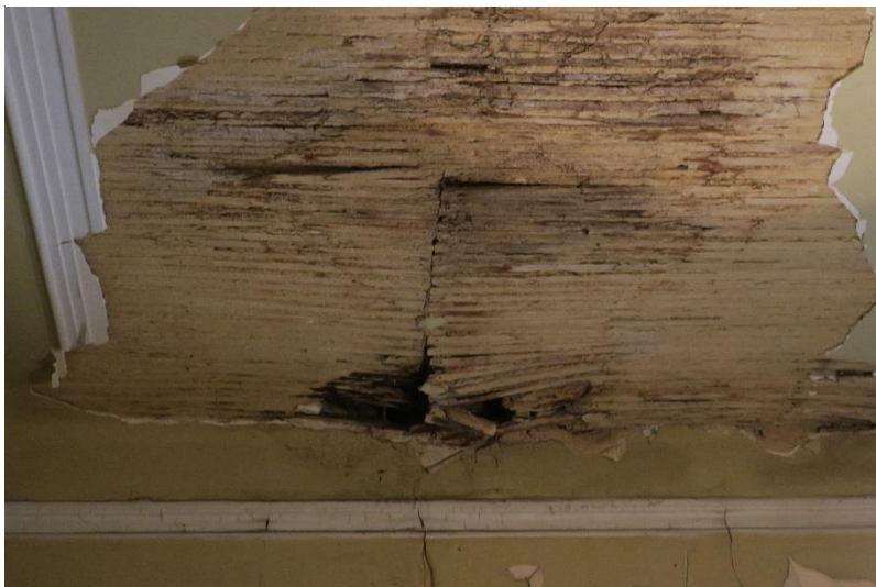
Fotografia 1 - Estado atual do piso 1 visto do R/C
